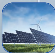
太阳能光伏板 PV Module
